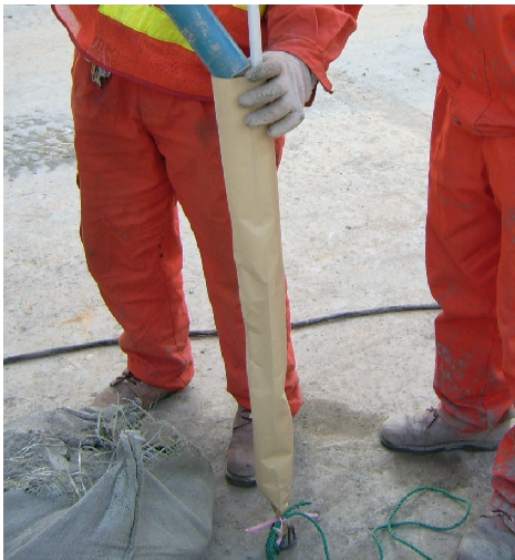
图8 锚头上加水泥粉图片
