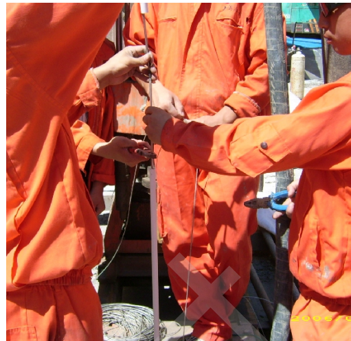
图9 位移计杆件安装图
