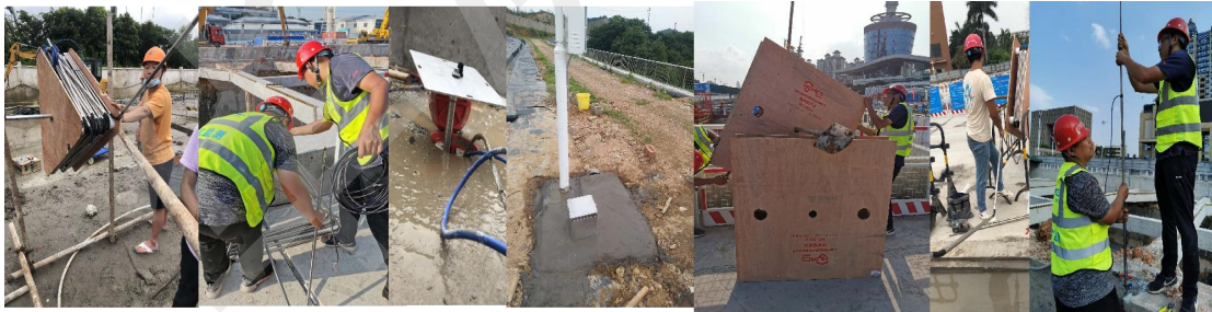
高铁基坑 基坑监测 水利大坝 地质灾害边坡 地铁基坑 水利大坝 建筑基坑
