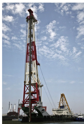
传统打桩船施工定位
