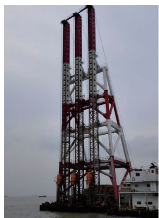
上海某工程浅水地基加固定位系统
